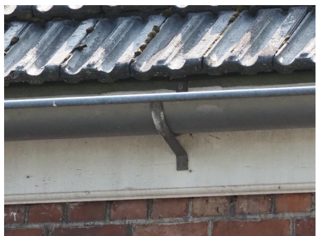
Figuur 3: Detail foto 1 dakpannen, de dakpannen zijn volledig afgesloten
