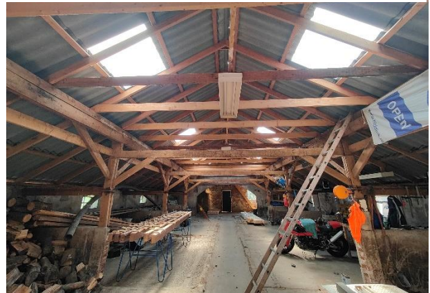
Figuur 9: Binnenkant varkenschuur, enkel golfplaten en geen microklimaat
