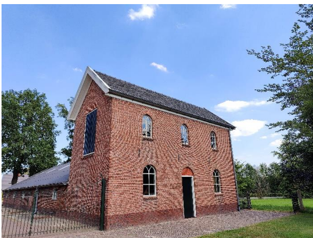
Figuur 4: Voorkant dakpannen voorste gebouw
