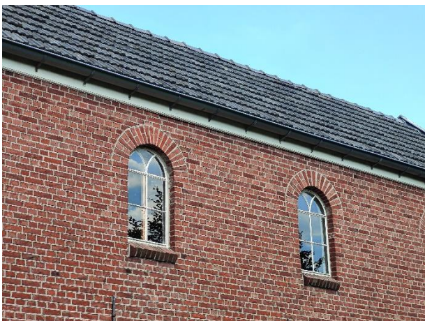
Figuur 6: voor aanzicht dakpannen en houtbeplating voorste gebouw
