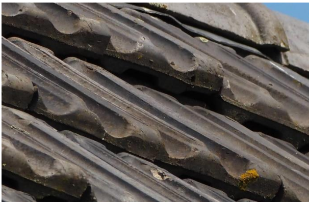
Figuur 11: Detail foto 2 dakpannen voorste gebouw, potentie voor gewone dwergvleermuis
