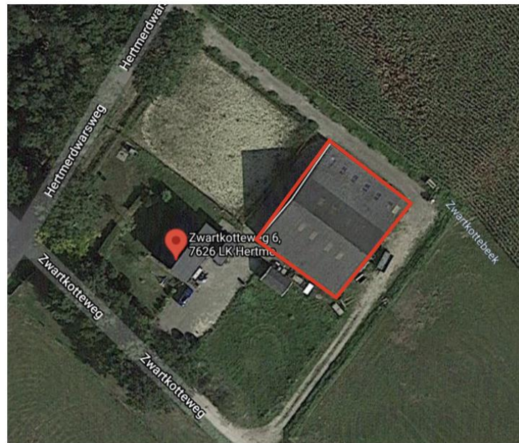
Sloop- en bouwlocatie Zwartkotteweg 6, Hertme (525 m2)
