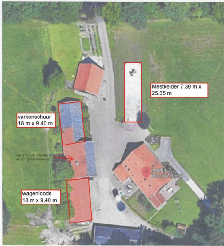
Slooplocatie Loodijk 2, Borne (525,75 m2)
