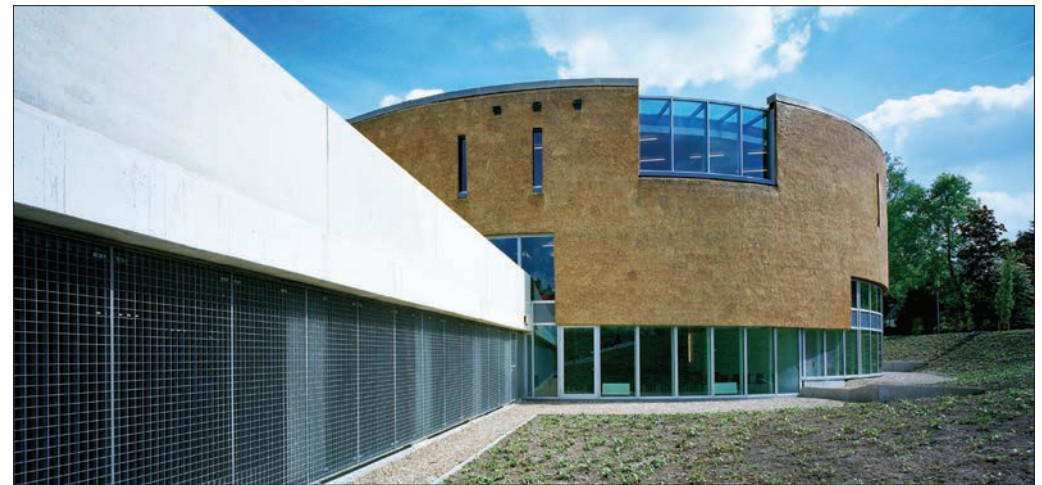
Figuur 5 - achter: de bibliotheek in het Kulturhus; voor: het kelderdek van de (half-) ondergrondse parkeergarage (Foto: MAS architectuur dd. 2004).
