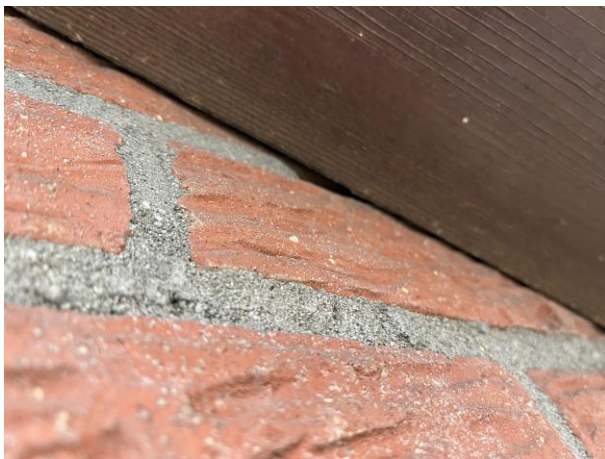
Betimmering van het dakoverstek sluit naadloos aan op de buitengevels.
