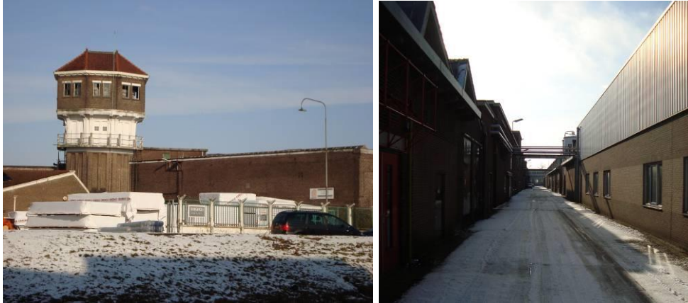
Afbeelding: De monumentale watertoren (links) en de karakteristieke fabrieksbebouwing (rechts) in het plangebied.
