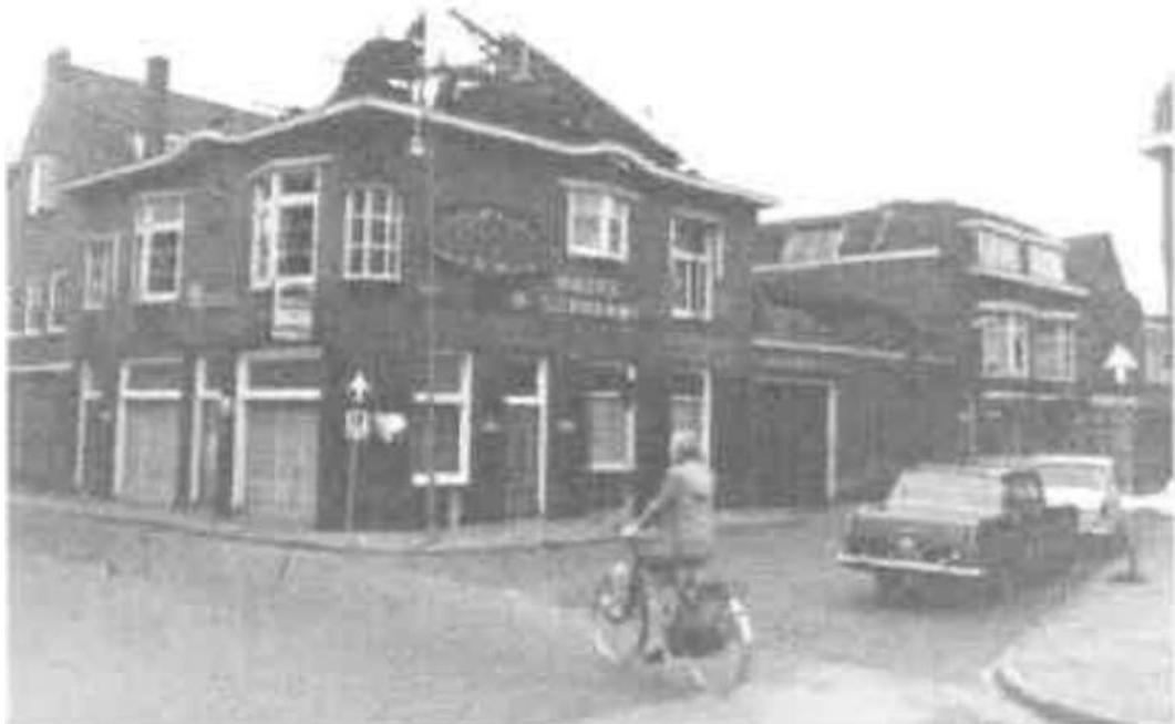
Afbeelding 10. Het voormalige pand in het plangebied op de hoek van de Tuinstraat - Holtjesstraat. Situatie voor 1973. Bron: Historische Kring Almelo (met dank aan H. Holtman).
