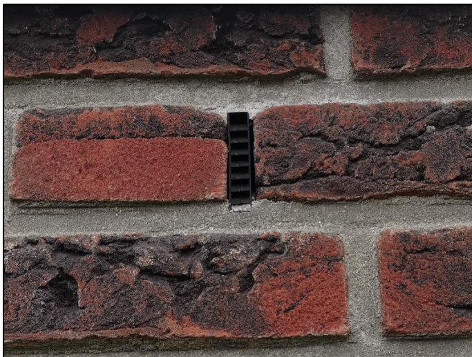
Figuur 6.1: Impressie van een stootvoeg, voorzien van een bijenbekje.
