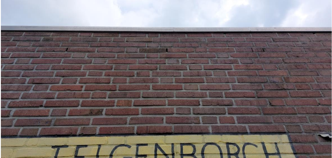
Figuur 4.1 Open stootvoegen en ruimte bij daktrim welke mogelijkheden kunnen bieden tot verblijfplaatsen van vleermuizen in de spouwmuur van de scholen. Bron foto's: Ecogroen.
