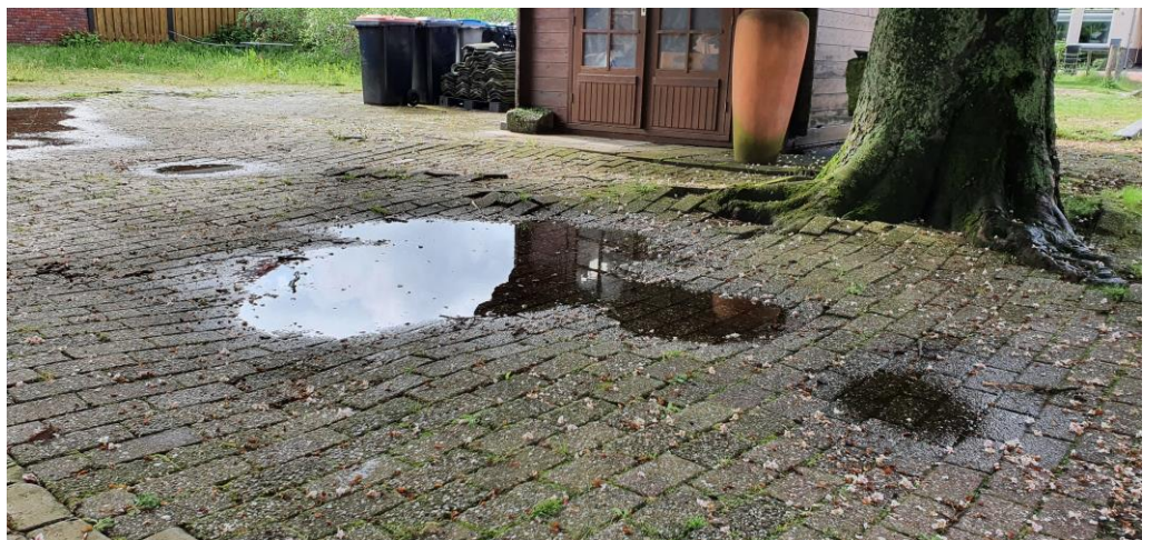
Afbeelding 5: Zeer sterke wortelopdruk in de verhardingen op de kavel.
