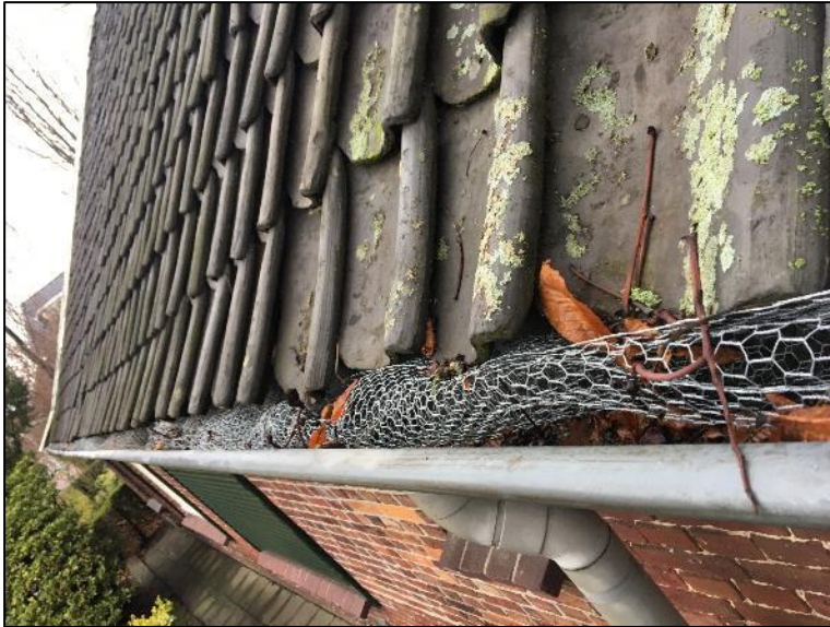
Gespannen gaas voor de onderste rij dakpannen.
