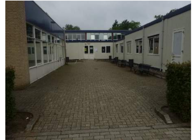
Schoolgebouw vanaf parkeerterrein
