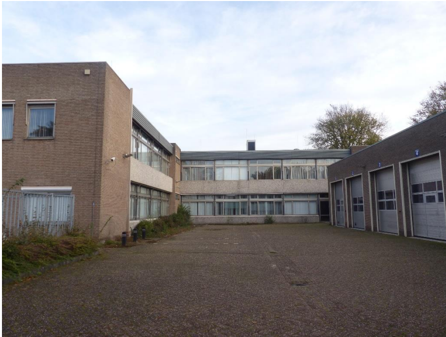
Foto 3 De 'binnenzijde' van het pand, met rechts de garages.
