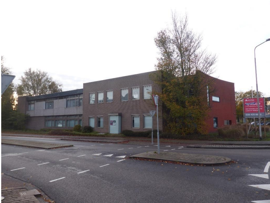
Foto 1 Het vooraanzicht van het gebouw.
