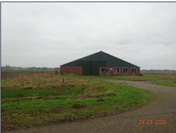
Afbeelding 3. Te slopen koeienstal.
