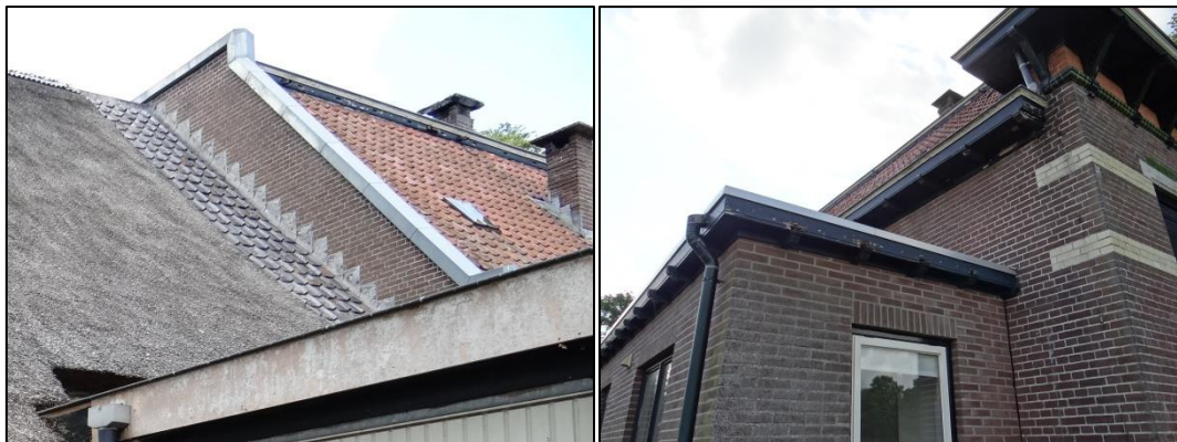
Foto's 9 en 10. Links de loodslabben tussen het woonhuis en de aanbouw. Rechts de houten boeiboorden en dakrand van het woonhuis.
