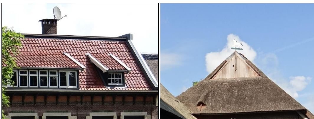
Foto's 7 en 8. Links het pannendak van de woning en de dakgoot. Rechts het uilengat in de aanbouw.
