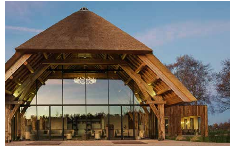
Staat, huis: rieten gevel en dak
