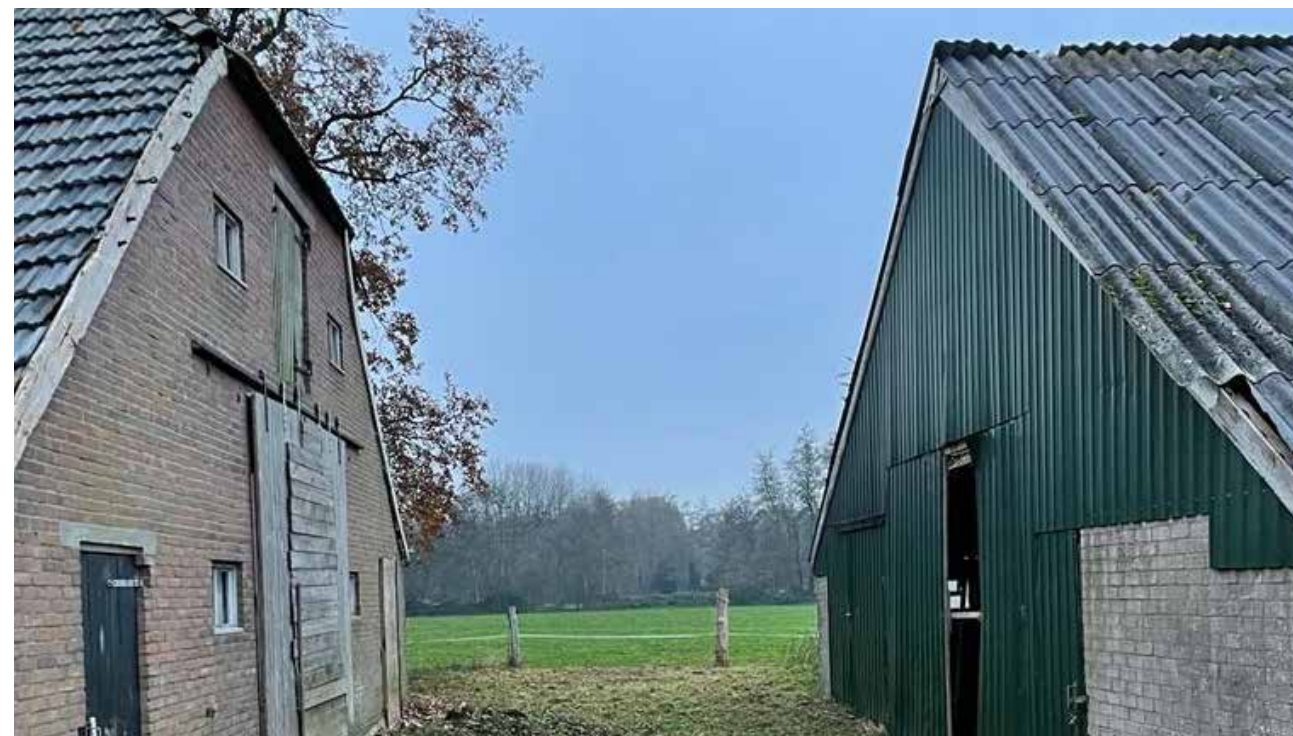
doorzicht tussen boerderij en schuur naar weiland westzijde
