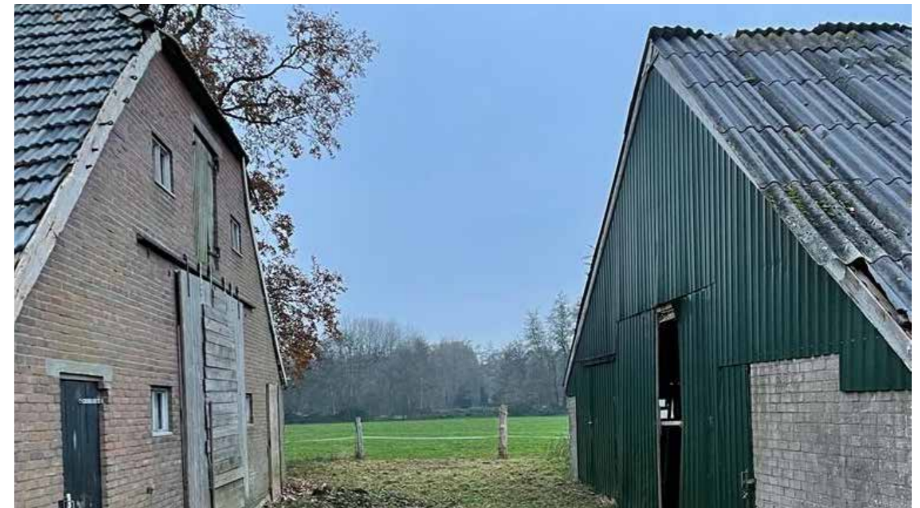
doorzicht tussen boerderij en schuur naar weiland westzijde
