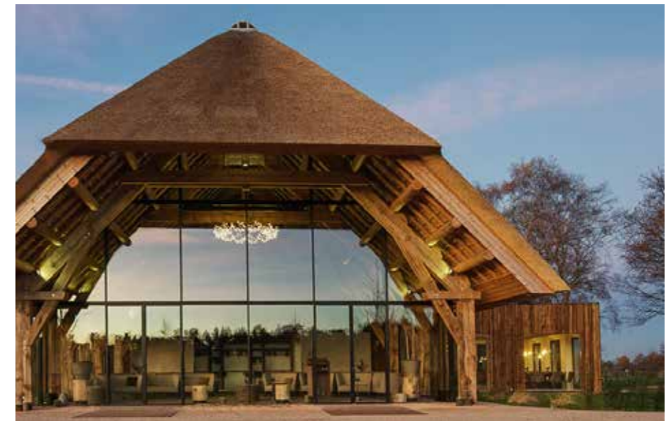
Staat, huis: rieten gevel en dak
