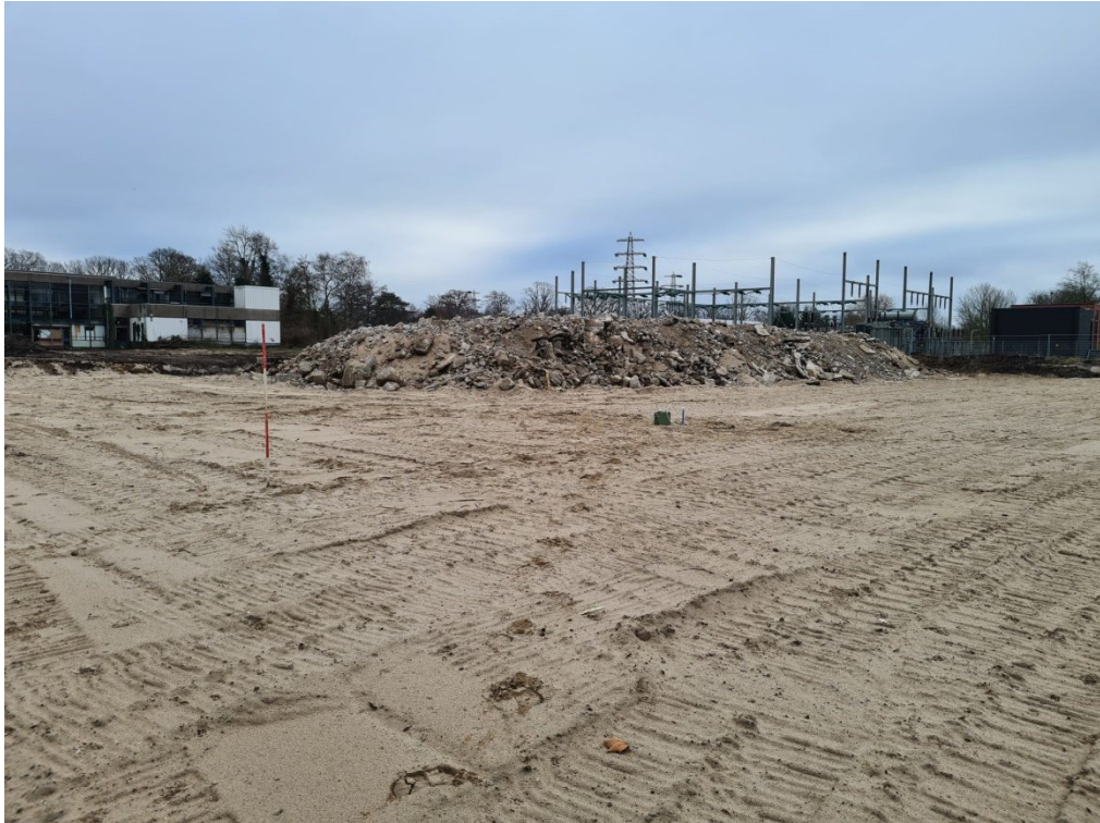
Foto 1: overzicht recent verwijderde bebouwing
