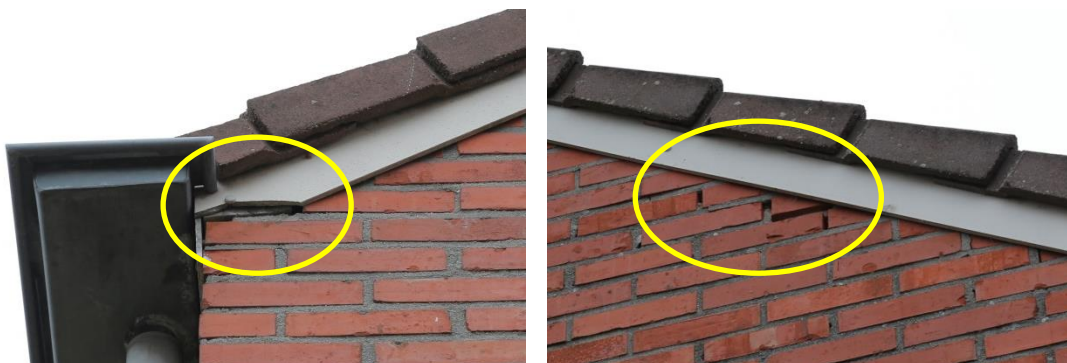
Foto 4 Openingen in de gevel
