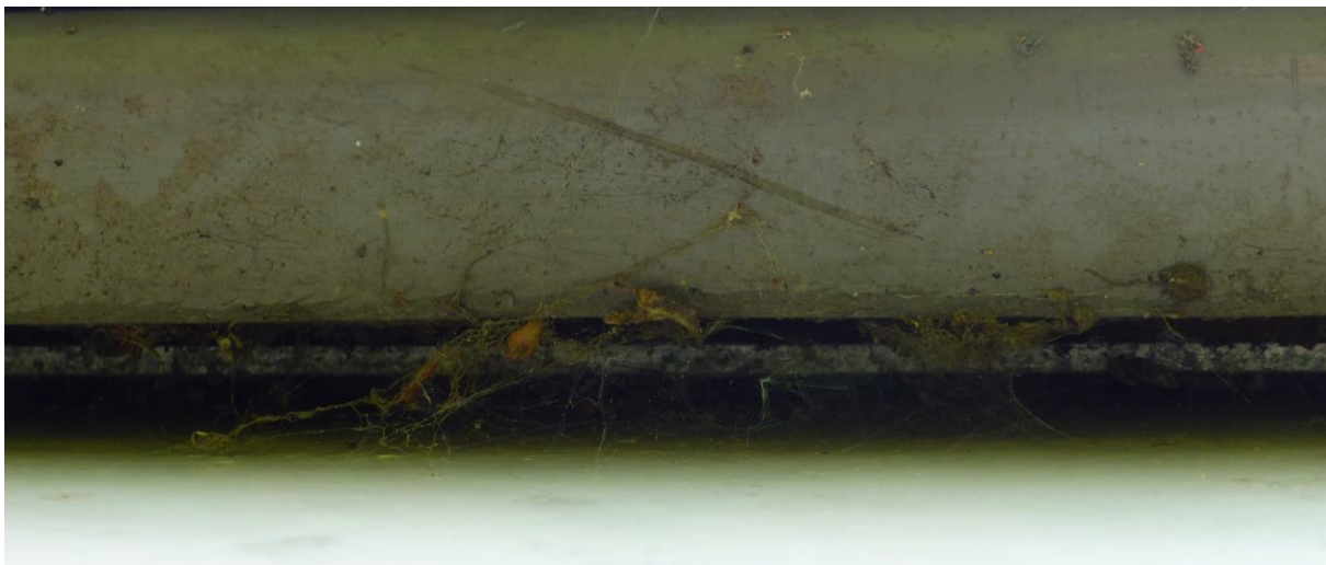
Figuur 4.4 De gleuf in het huisje is maximaal 1 cm breed, 0,5 cm hoog en verder rondom geheel afgesloten.
