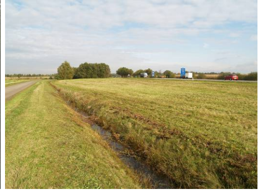
Locatie waar de nieuwe tunnel zal komen
