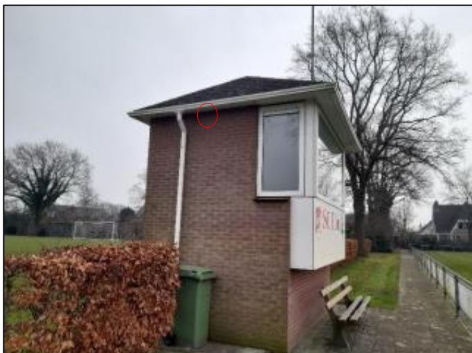
Figuur 2.4 Wedstrijdhok met open stootvoegen (rood omlijnd). (bron WSP, projectnummer SOL022996).
