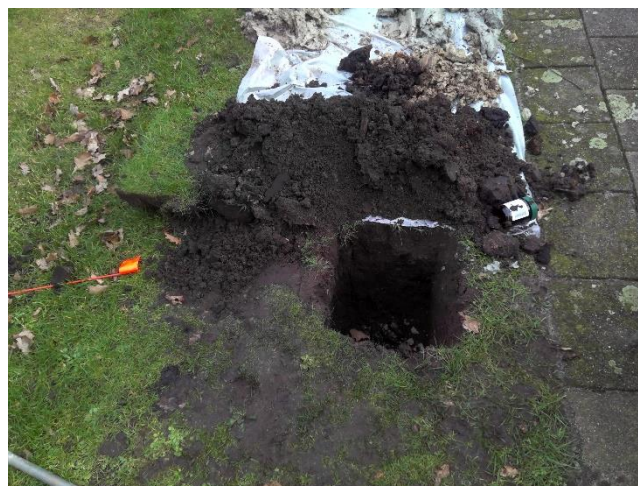
Foto 2: Asbestinspectiegat V10
