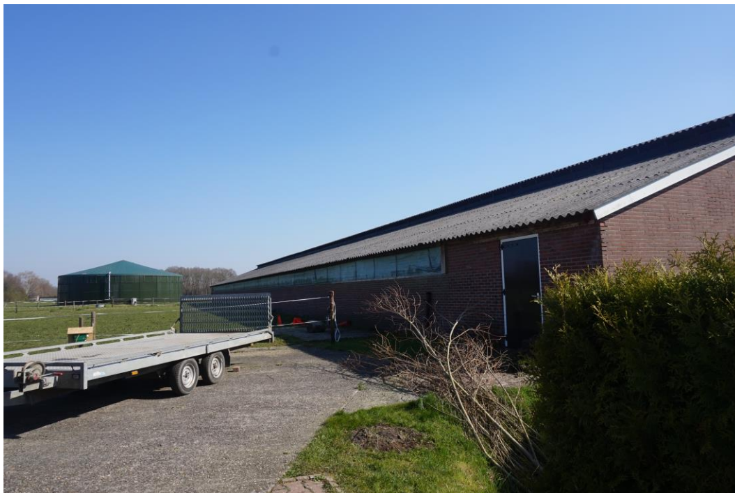
Figuur 2.2. Noordzijde te slopen schuren en mestsilo.
