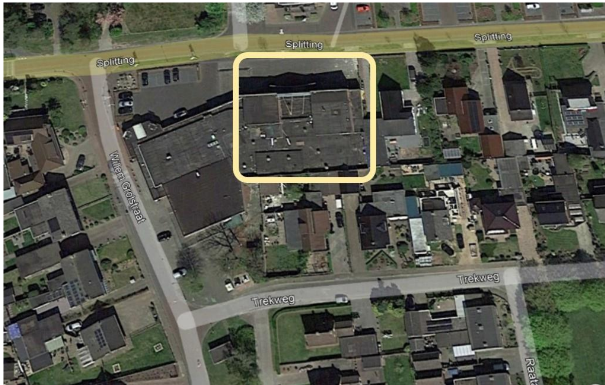
Figuur 2: Geel kader: te slopen bebouwing. Bron: Google Earth.
