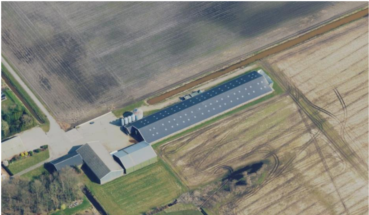
Afbeelding, bouwlocatie Weedingerkanaal ZZ 68 (Bron: Street Smart) 21 maart 2022
