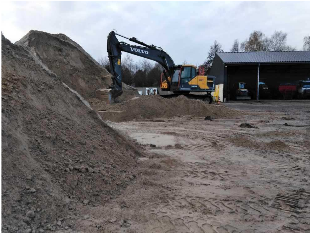
Foto 1. Hoek Kollingsveenweg/Oosterwijk W.Z., Emmen
