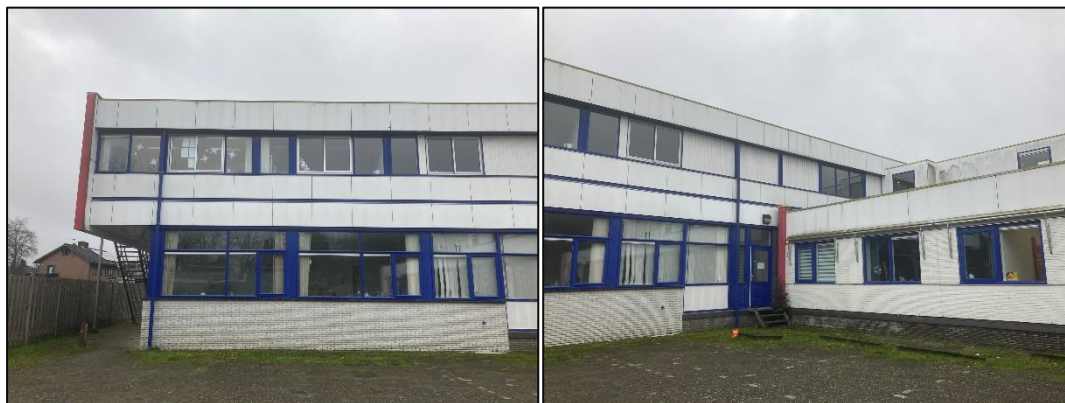
Figuur 2.3 (links): Alle gevels van het gebouw zijn vanaf de eerste verdieping bedekt met trespa/HPL-platen, zo ook deze zuidvleugel aan de oostzijde; Figuur 2.4 (rechts): Oostgevel.
