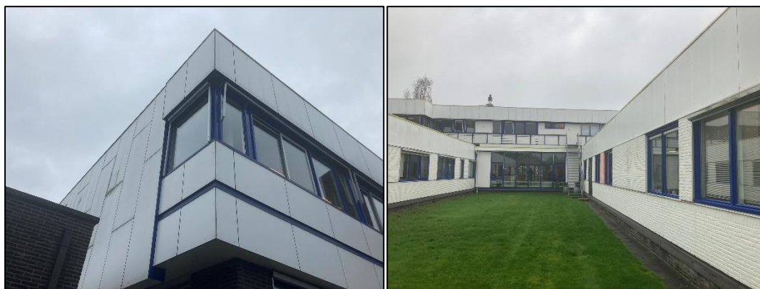
Figuur 2.9 (links): Een hoek van de zuidgevel; Figuur 2.10 (rechts): De zuidgevel met twee vleugels. Tussen de vleugels ligt intensief beheerd gazon.
