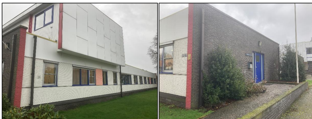
Figuur 2.11 (links): De westgevel; Figuur 2.12 (rechts): De noordgevel.
