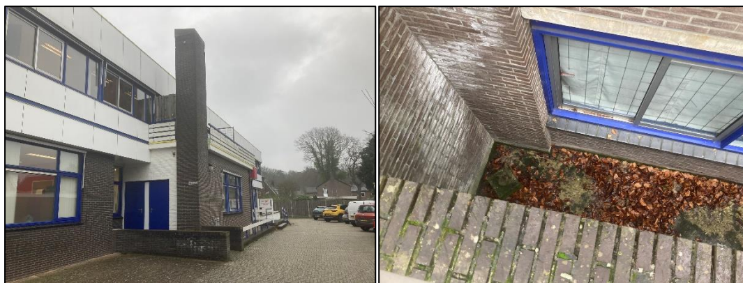
Figuur 2.7 (links): De westgevel; Figuur 2.8 (rechts): Voor de kelder verdieping ligt een ventilatiegoot.
