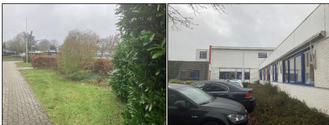
Figuur 2.13 (links): Struweel en gazon aan de noordzijde; Figuur 2.14 (rechts): De oostgevel met struweel en een parkeerplaats.
