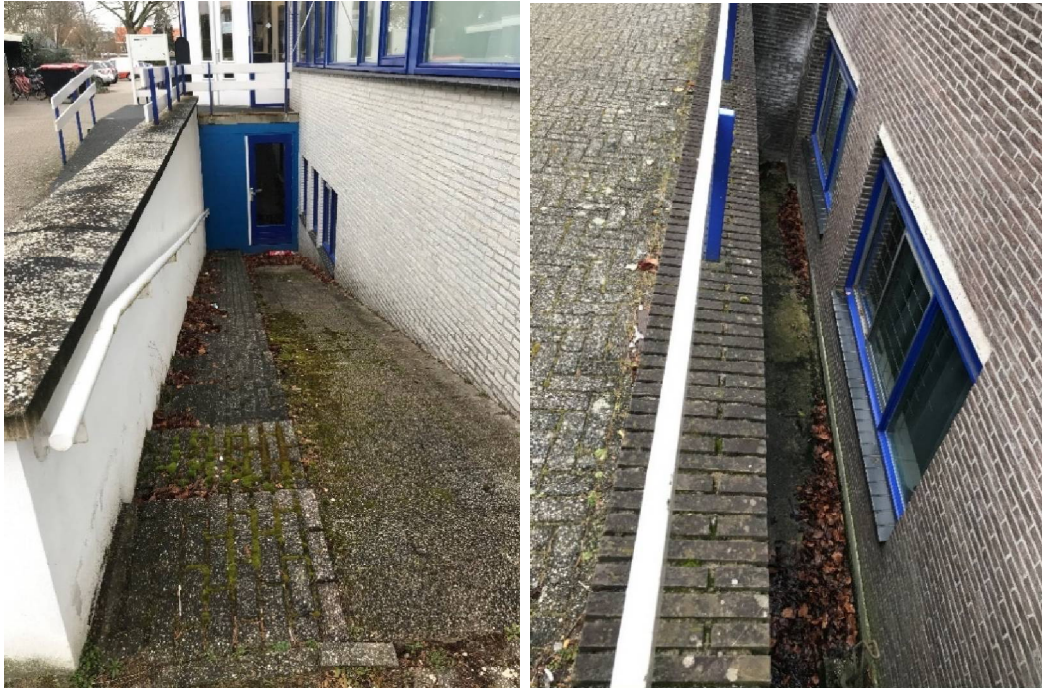
Afbeelding 2. Onderkeldering van het huidige pand. Foto's genomen aan de zuidoostzijde van het gebouw in westelijke richting.
