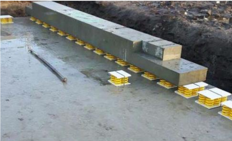
Figuur 27 Dubbele fundering met stalen veerdozen (project in Prinsenbeek)
