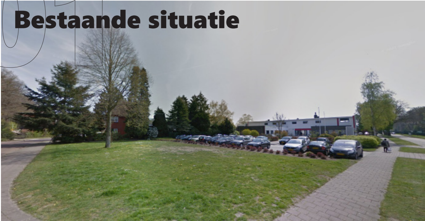
PLANGEBIED - Hoek Parallelweg - Veenkampenweg Hoek Sedna terrein met zicht op parkeerplaats en te slopen pand
