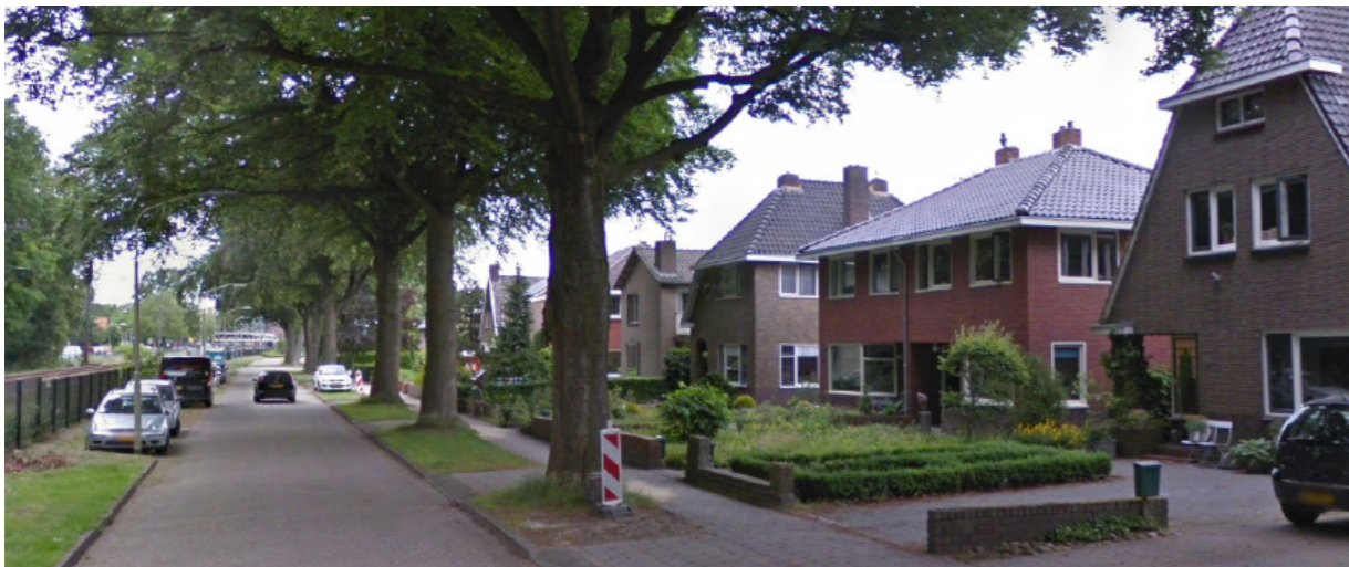
OMGEVING - Parallelweg Diversiteit in nokrichting, kleurstelling en kapvorm met strakke voorgevellijn die zorgt voor eenheid
