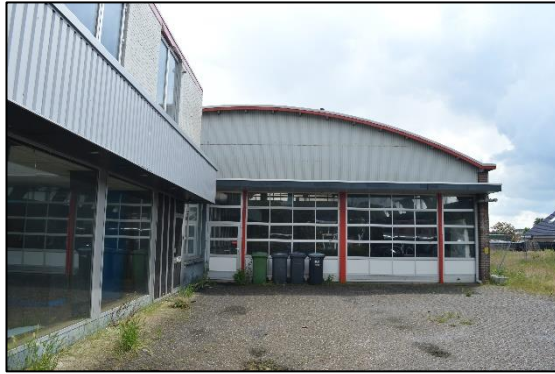
Afbeelding 2.2. Voorzijde pand gebruikt door autobedrijf.
