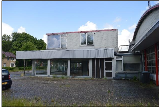
Afbeelding 2.10. Showroom met appartement.
