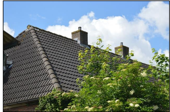
Afbeelding 2.11. Dakpannen dak van woonhuis.
