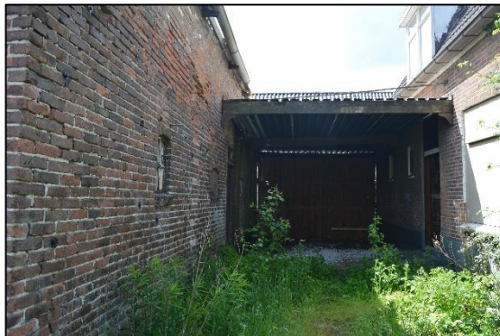
Afbeelding 2.4. Overkapping achter woonhuis.
