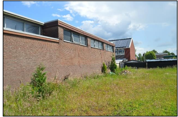
Afbeelding 2.3. Zuidzijde pand gebruikt door autobedrijf.
