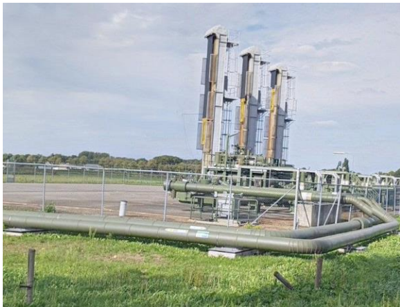
Foto 3. Huidige boorput in Nederland (NAM locatie Schoonebeek 3100), gesitueerd langs de Wilmsburgweg en het Schoonerbeekerdiep, richting de grens met Duitsland. Bron: Google street view.
