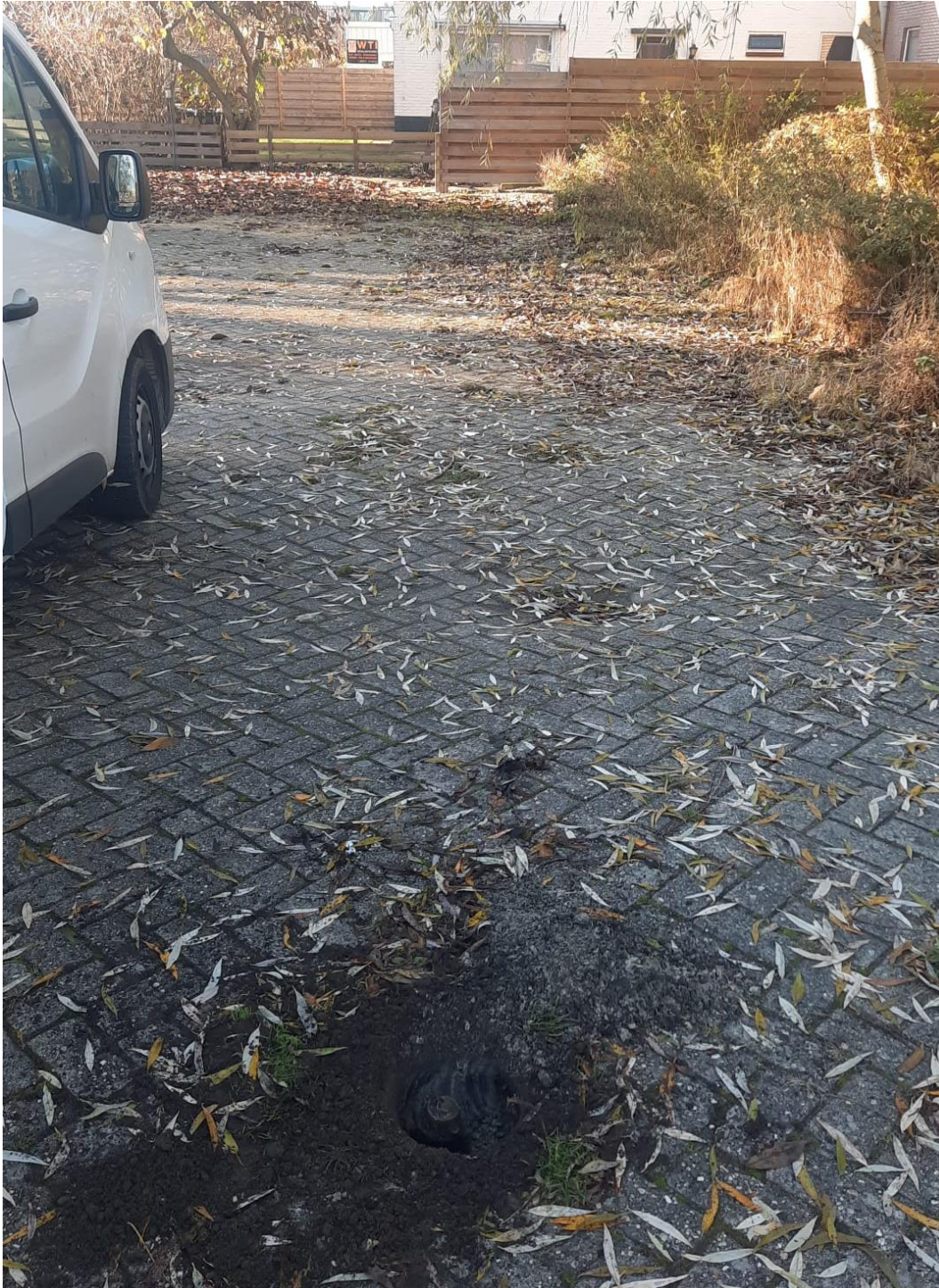
Foto 1: Vulpunt van de nog aanwezige ondergrondse benzinetank op de zuidoostelijke hoek van de onderzoekslocatie.
