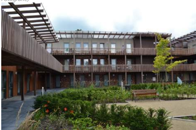
Transparante galerij met dakconstructie en groene binnenplaats Hof van Erica (bron: Bureau Noordeloos)
