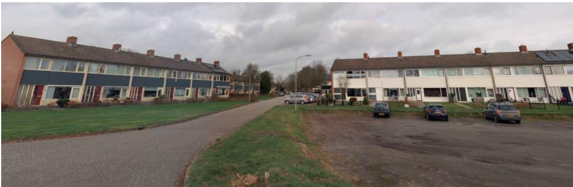
Bestaande rijwoningen ten noorden en westen van het plangebied
