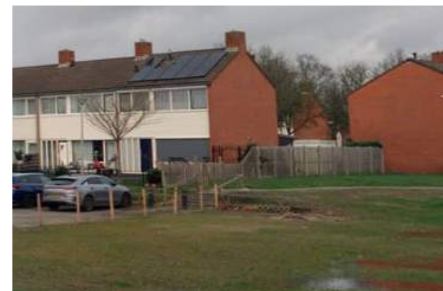
Blinde zijgevels van de rijwoningen met schuttingen
