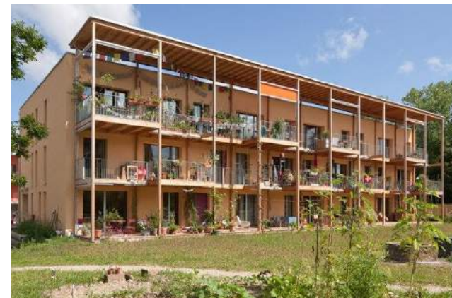
Voorbeeld van toepassing flauwe kap boven balkons, kan ook worden toegepast boven galerij.
