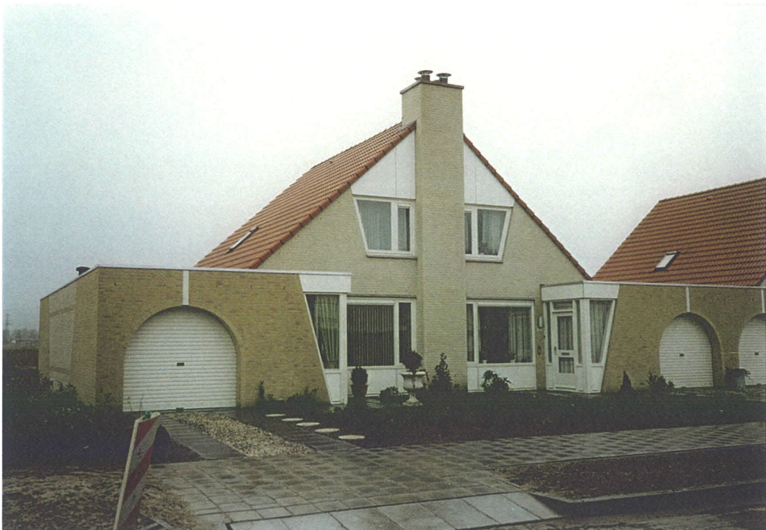
11 De aparte vormgeving van de garages heeft een grote meerwaarde in de beleving van de wijk.
