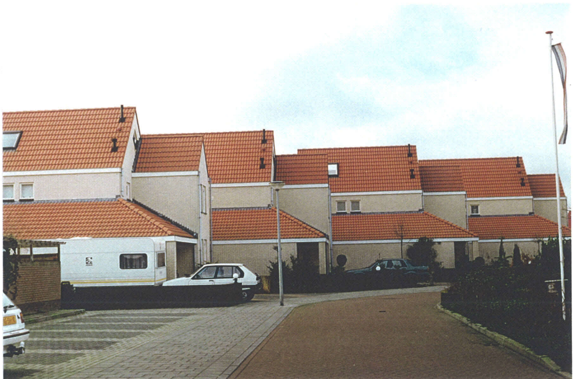
8 Ook hier apart vormgegeven daken. Door het ontbreken van accenten in kleur komt het geheel nogal saai over.
