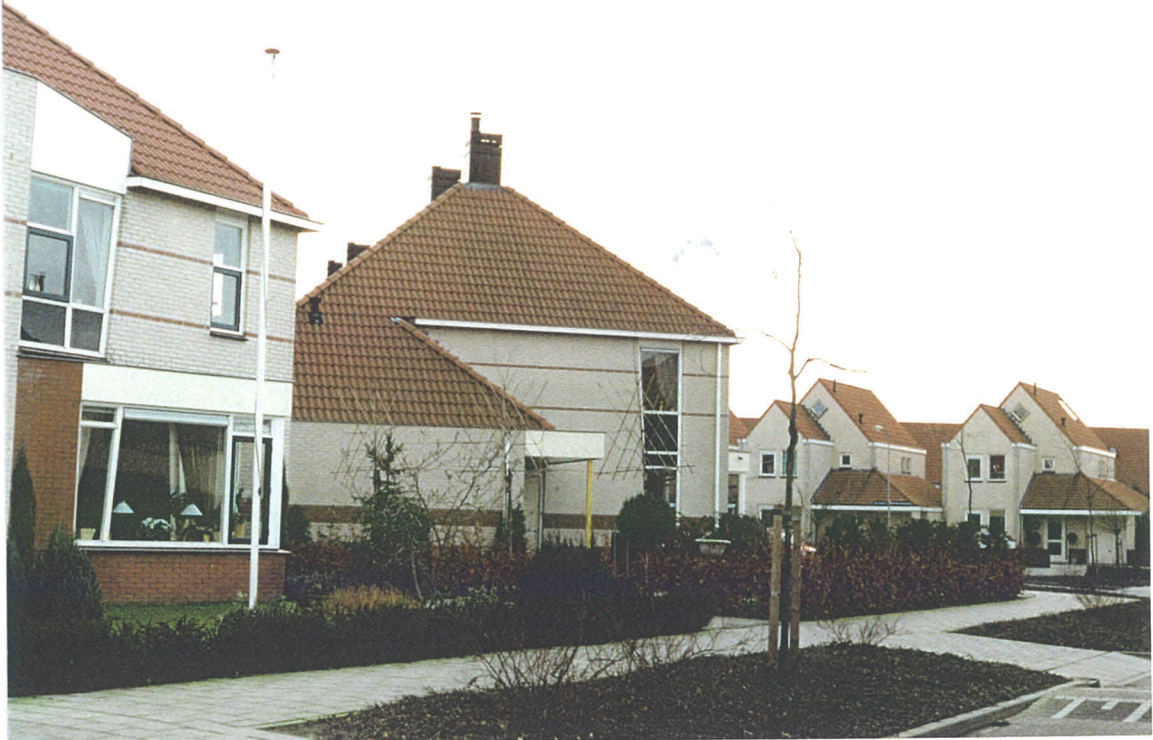
7 Verschillende dakvormen geven een speels aanzicht aan de wijk.
