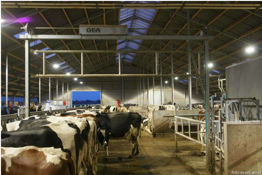
Afbeelding 3: Voorbeeld goede positionering lichtbronnen, het vloeroppervlak wordt verlicht
