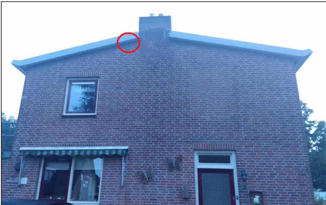
Figuur 43 Zomerverblijf gewone dwergvleermuis Burg Gratamaplein 20 Veenoord
