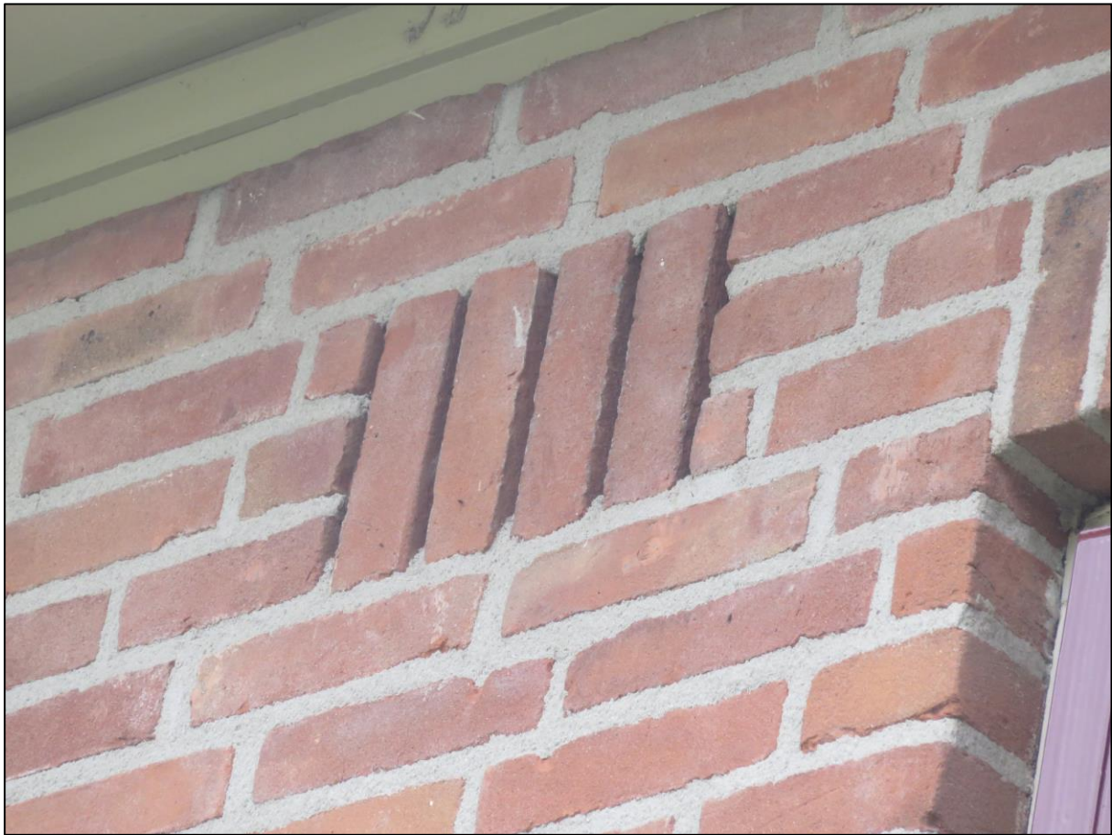
Figuur 2.2. Stootvoegen in de woningen aan het Burgemeester Gratamaplein te Veenoord.
