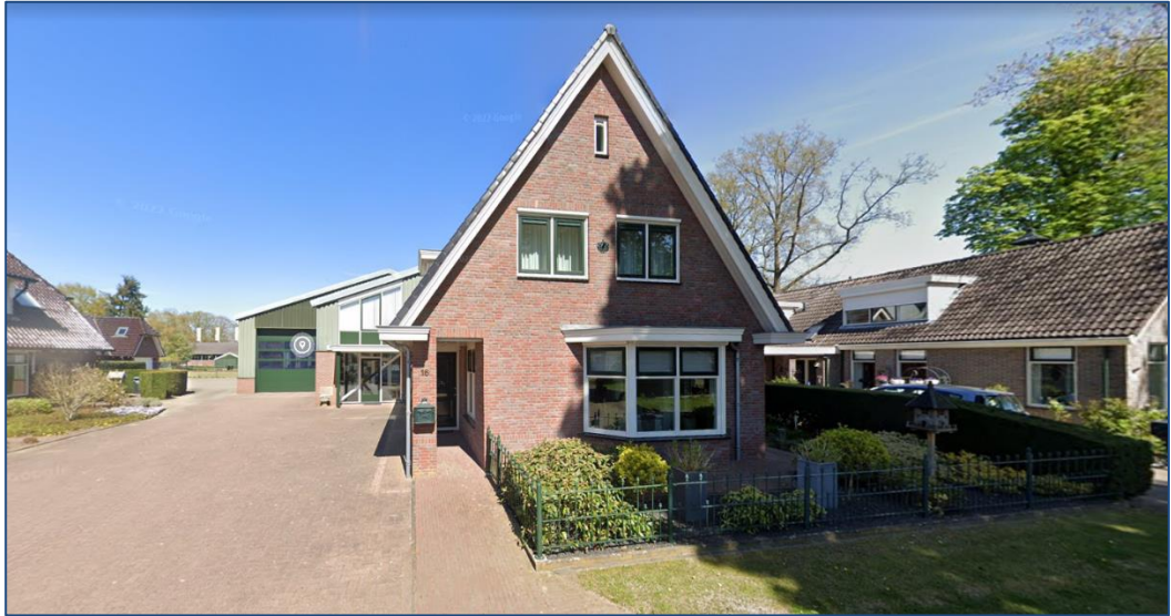
Fig. 2.5: Weergave van het bestaande pand Oude Dalerveensestraat 16
