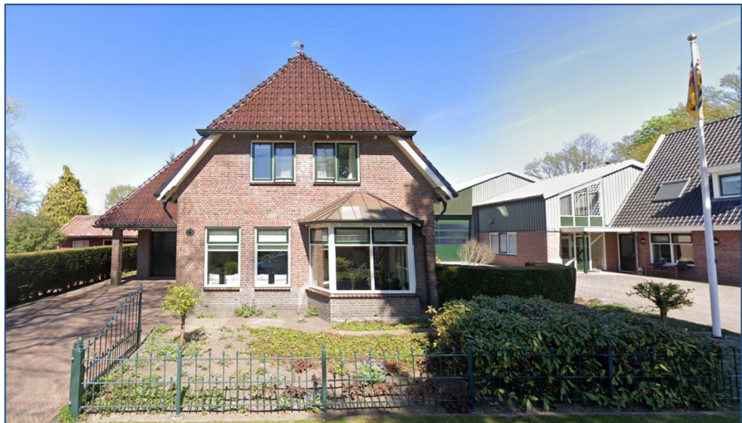
Fig. 2.4: Weergave van het bestaande pand Oude Dalerveensestraat 14
