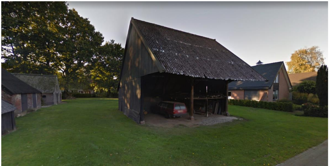
Figuur 2.6 : foto straatbeeld ter plaatse van De Steeg 4 – de te slopen kapschuur
