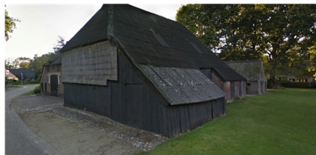
Verharding tussen de bebouwing en de openbare weg van klinkers en keien
