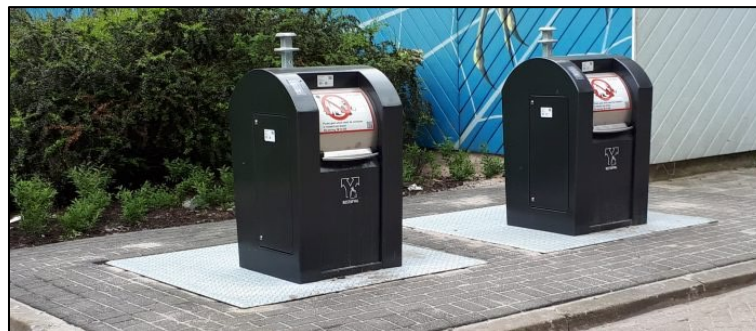
Figuur 35 Centrale ondergrondse afvalvoorziening nabij entree
