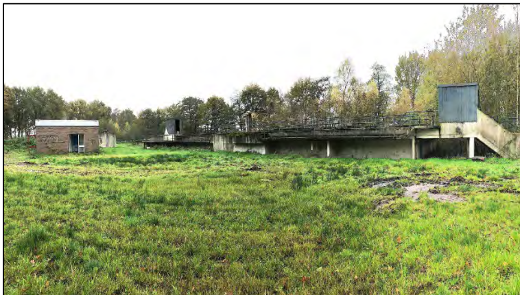
Figuur 18 Bestaande opstallen vml. RWZI
