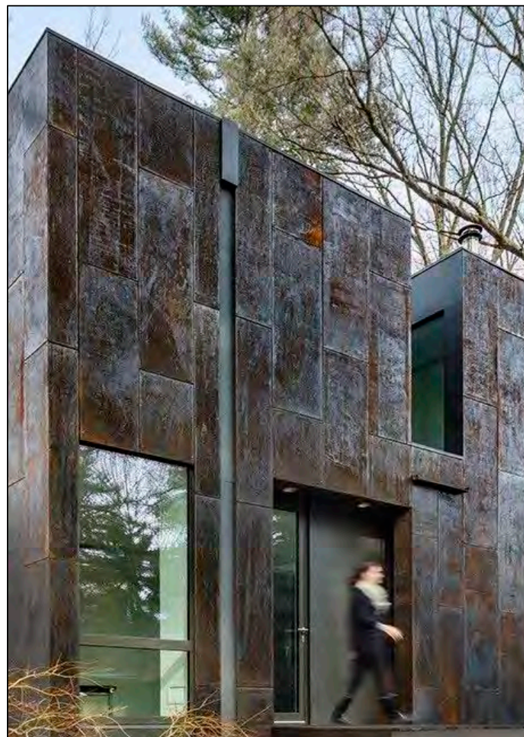
Figuur 61 Cortenstaal gevel
