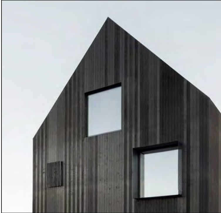
Figuur 48 Kleur kozijn ondergeschikt aan de gevel (glas als gat in de gevel)
