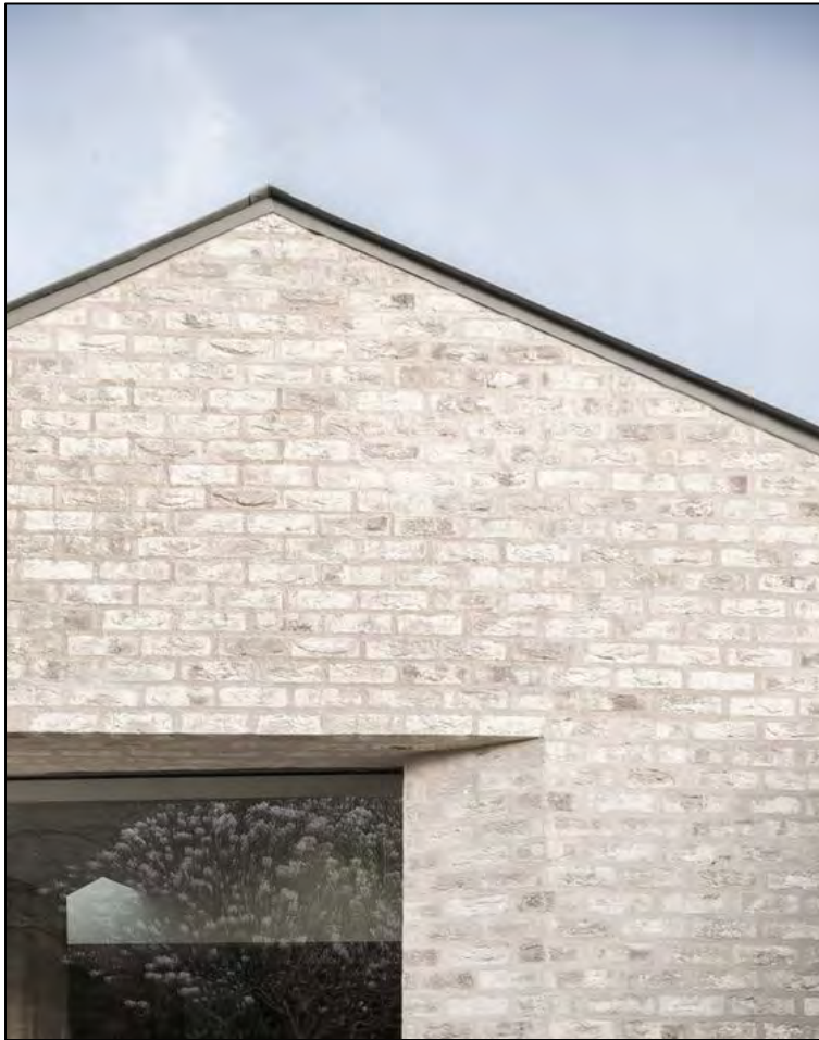
Figuur 58 Baksteen gevel licht
