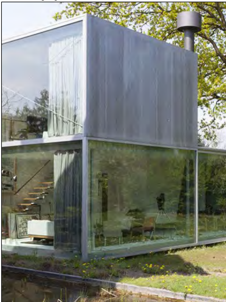
Figuur 60 Gevel metaal en glas
