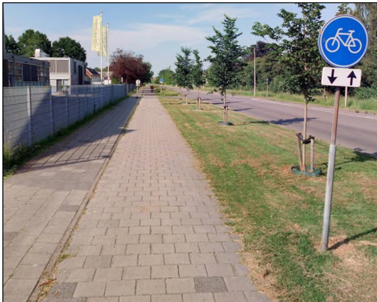
Figuur 3.10 Tweerichtingen fietspad langs de Graaf van Heiden Reinesteinlaan (bron: streetsmart 16-06-2021)
