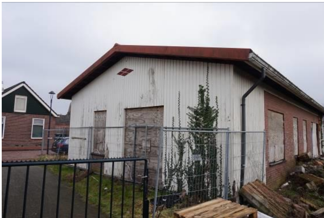
Figuur 2.4. Vooraanzicht bijgebouw vanaf pad Paul Krugerstraat
