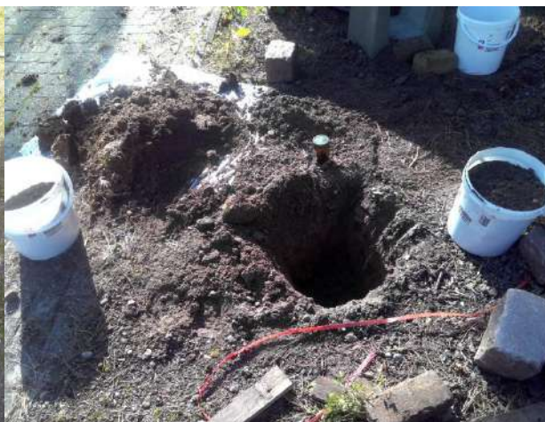
Foto 2: inspectiegat nr. G12
