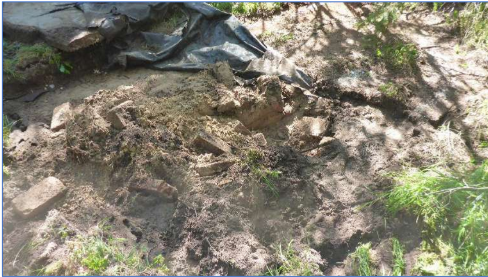
foto 17: opgenomen betonvloer met daaronder klinkers en zand
