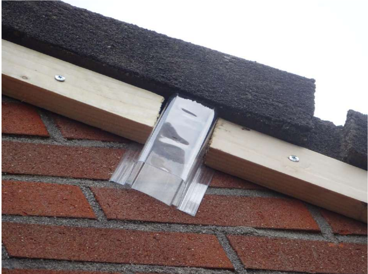
Figuur 4.2 Voorbeeld plaatsing exclusion flap
