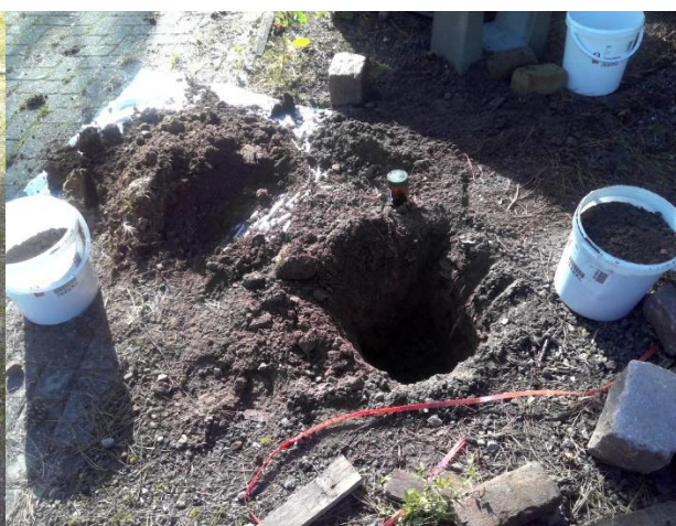
Foto 2: inspectiegat nr. G12
