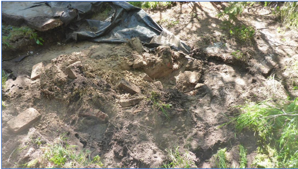
foto 17: opgenomen betonvloer met daaronder klinkers en zand
